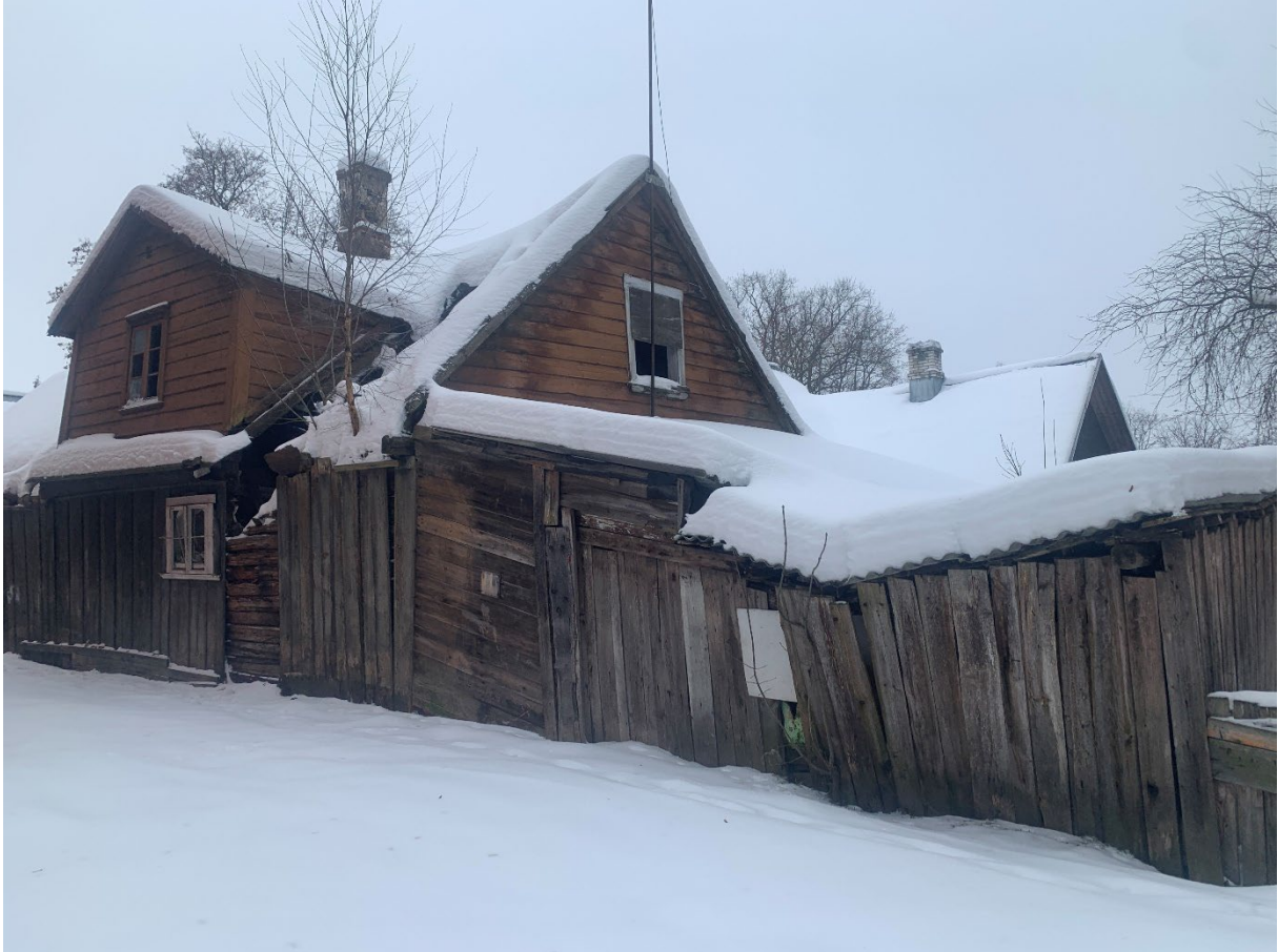
Foto 1. Uus tn 16//18 vana elamu ja selle kõrval olev kuur Uus tn 14 kinnistult vaadatuna. Hoone on tugevalt viltu vajunud Uus tn 14 kinnistu poole.
